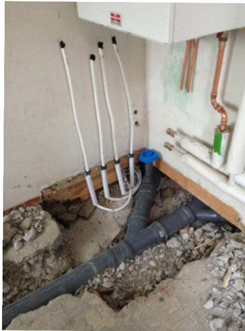
Rördragningen under fjärrvärmväxlaren (med avrinning för växlaren). Nya in-vattenledningar dragna till kök och gästwc
