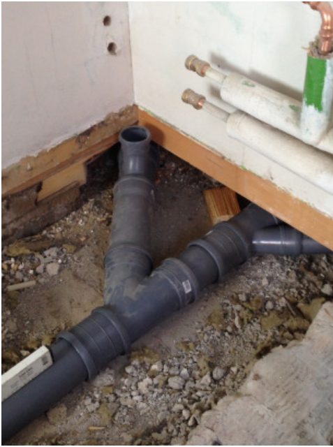
Rördragningen under fjärrvärmväxlaren (med avrinning för växlaren). Nya in-vattenledningar dragna till kök och gästwc
