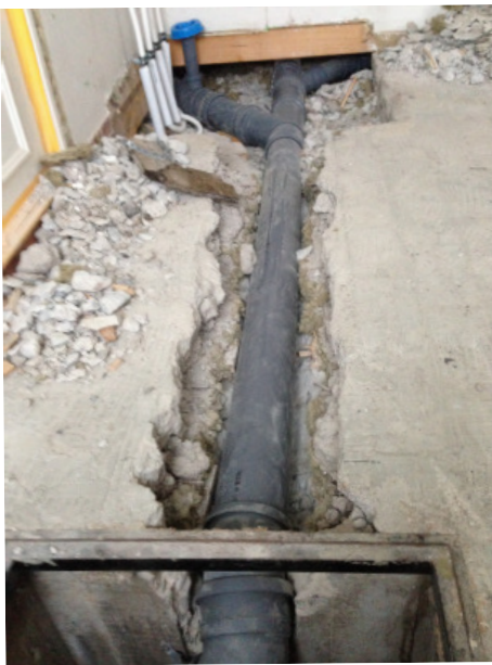
Från rensluckan, under värmväxlaren, vidare till badrum och lilla förrådet.
